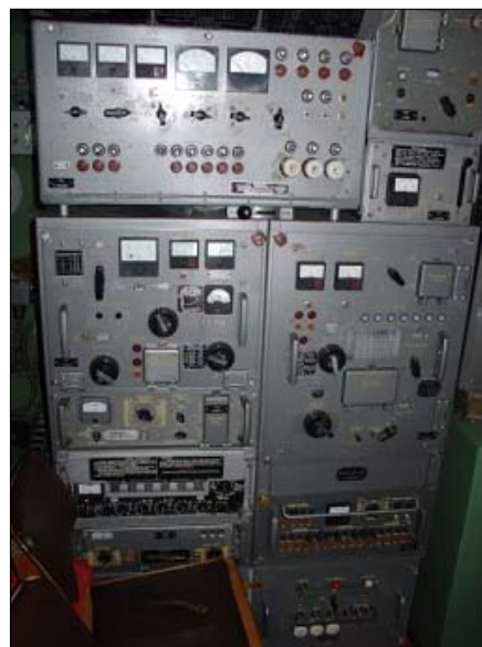
Sl. 37c. TX iz RTpS R-140, sa strane prednje ploče, izlazne snaga 1kW
