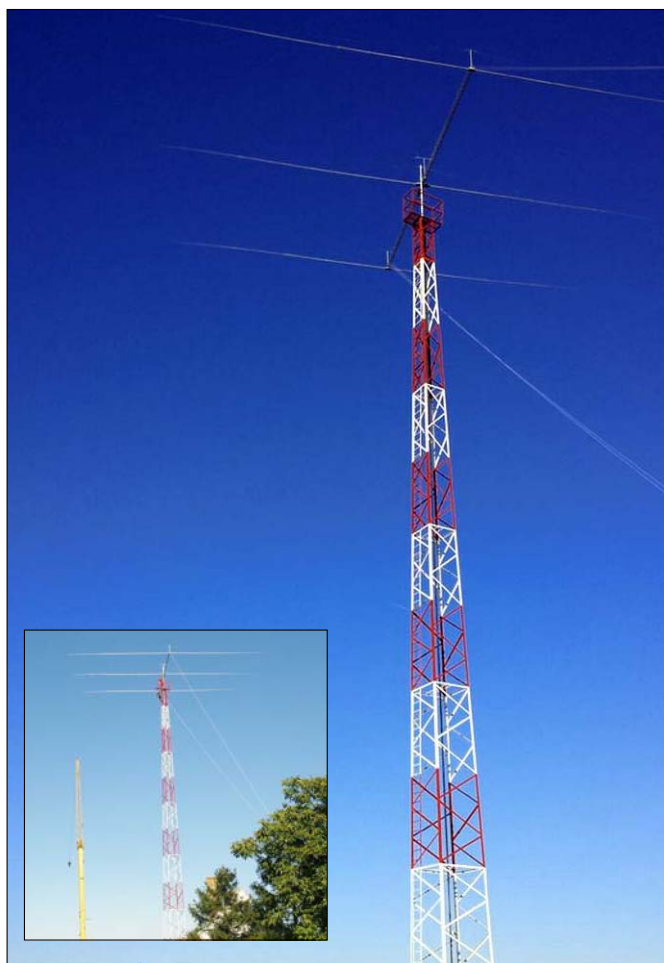
Sl. 5. Na lokaciji YU7AV je postavljena nova 3el antena za 7MHz na novom stubu
